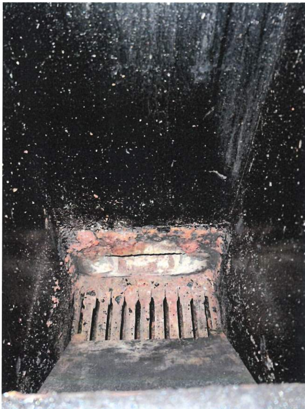
Rysunek 9 Dysza ceramiczna, element ograniczający pojemność komory spalania, ruszt
