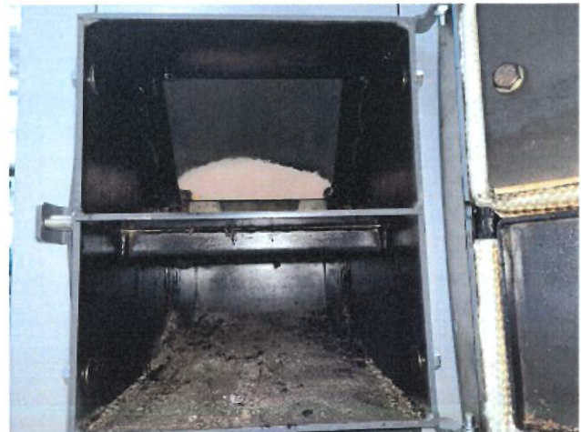
Rysunek 10 Element ograniczający pojemność komory spalania, ruszt, popielnik kotła
