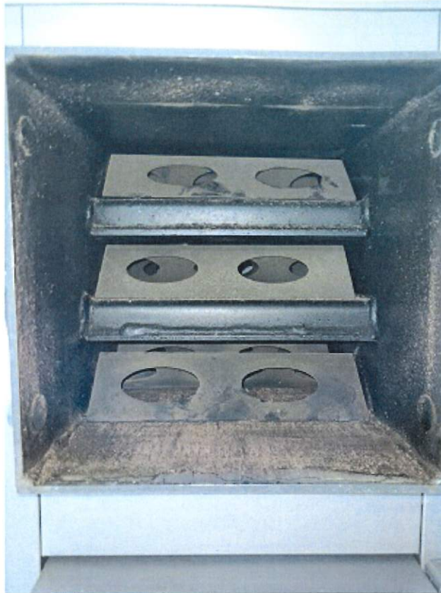
Rysunek 7 Wymiennik oraz zawirowywacze
